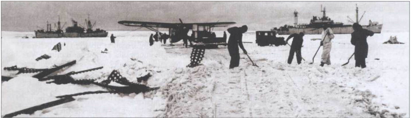
Mit Hilfe von Stahl und Schnee wird eine Eisspalte überbrückt. „Lütte America“ erhält ein Flugfeld aus gepreßtem Schnee, von hier aus werden 29 Aufklärungsflüge bis weit ins Landesinnere hinein unternommen.
