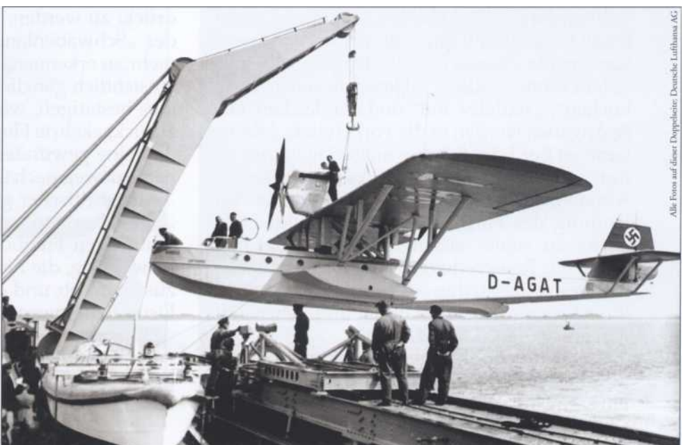
Der umklappbare Kran hebt das Flugboot zum nächsten Start auf die Katapultanlage Katapultanlage.
