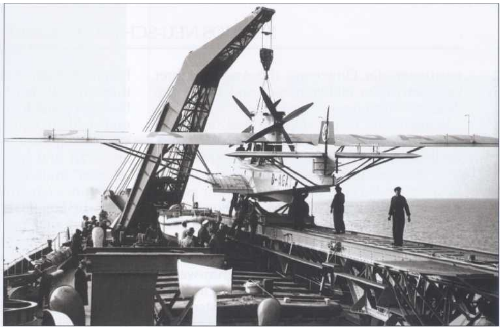
Die Krananlage der „Schwabenland“ muß vor dem Start des Flugbootes umgelegt werden.
