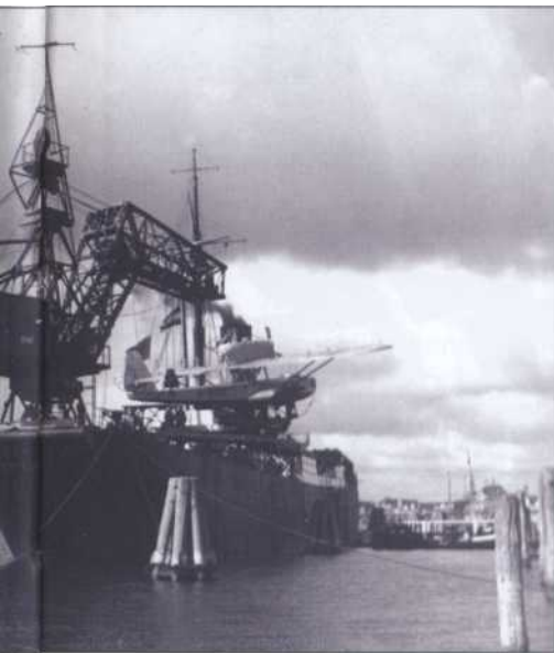
erhielt die „Westfalen“ einen Drehkran. Becker konnte Lasten von 15 Tonnen Schiffes von 15 Grad heben.
