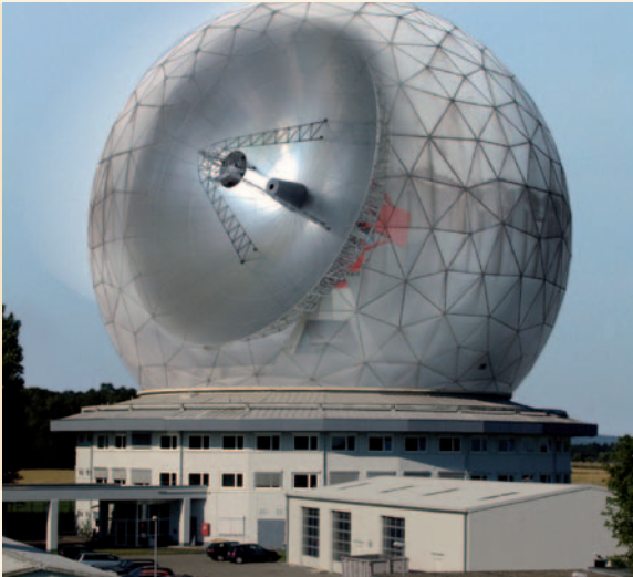
Die Fraunhofer-Gesellschaft analysiert mit dem Weltraumbeobachtungsradar TIRA Raumfahrtrückstände und andere Weltraumobjekte und trägt damit zur Sicherheit im Weltraum bei.
